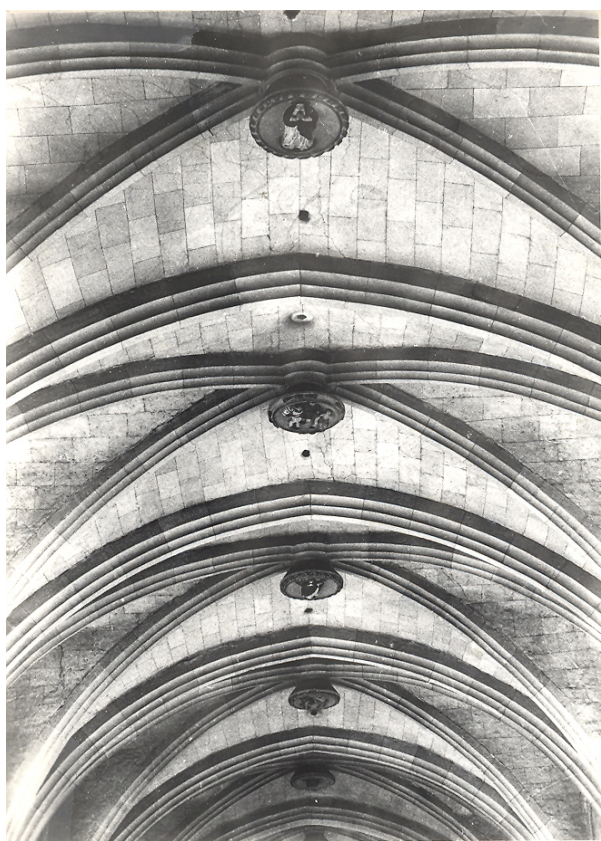
- figura 1: Voltes de creueria de la nau central.
