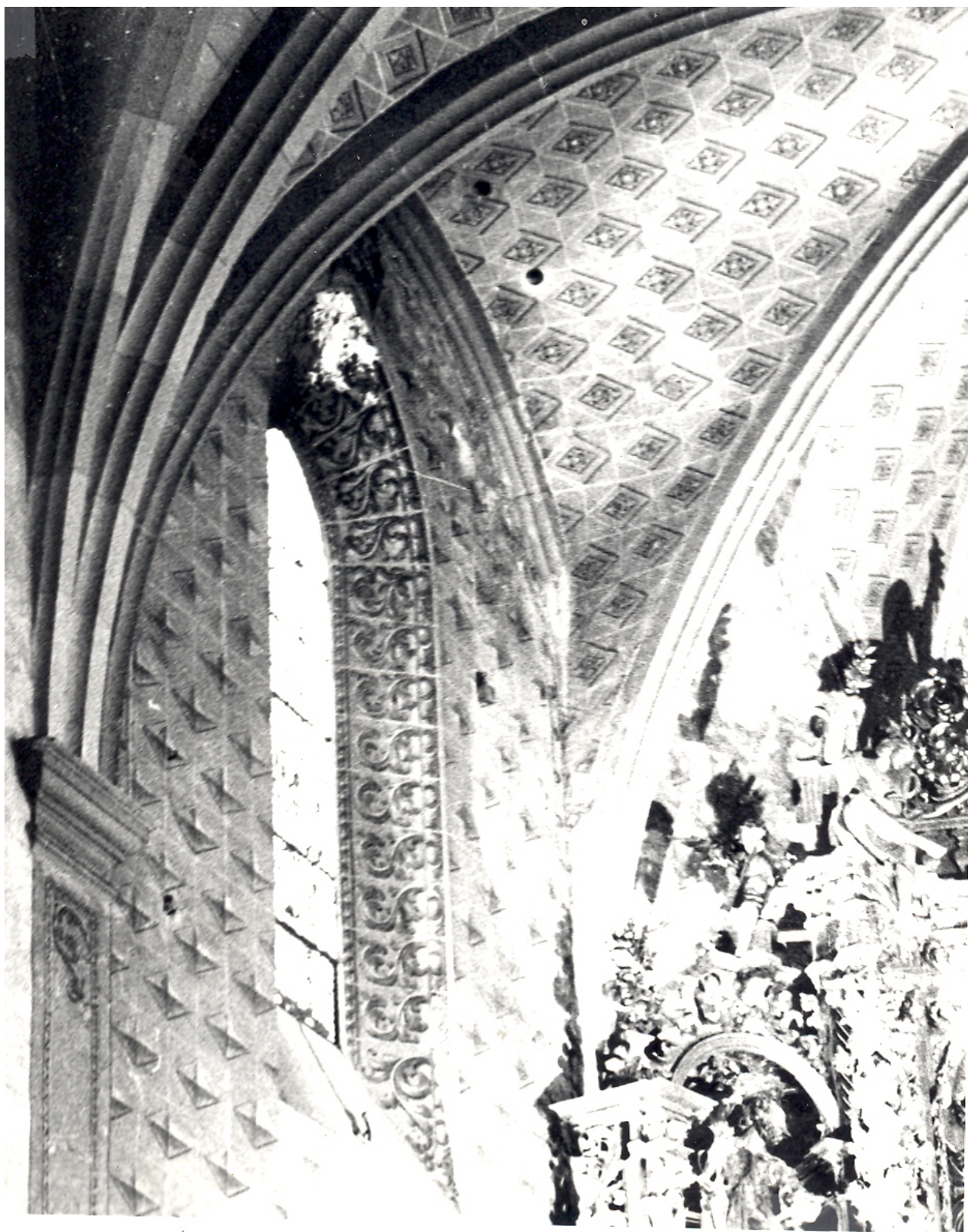
gura 2: Pintures als laterals. Finestrals i falses pilastres.
