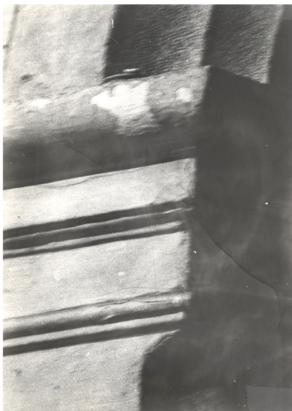
- figura 3: Motllura de les falses pilastres de les capelles laterals.
