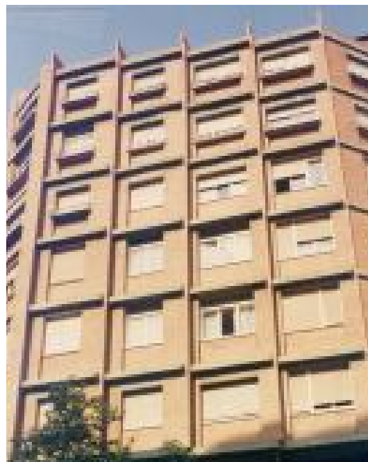
Edifici Rambla a L'Hospitalet/ Arq.Senillosa 1968
