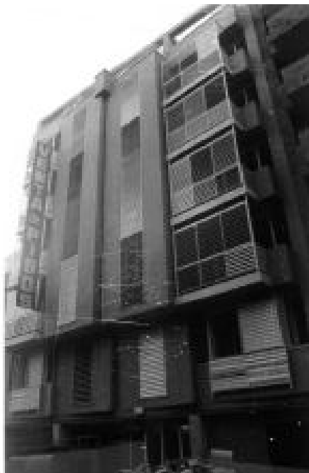
Edifici Encarnació. Acabat el 1977
