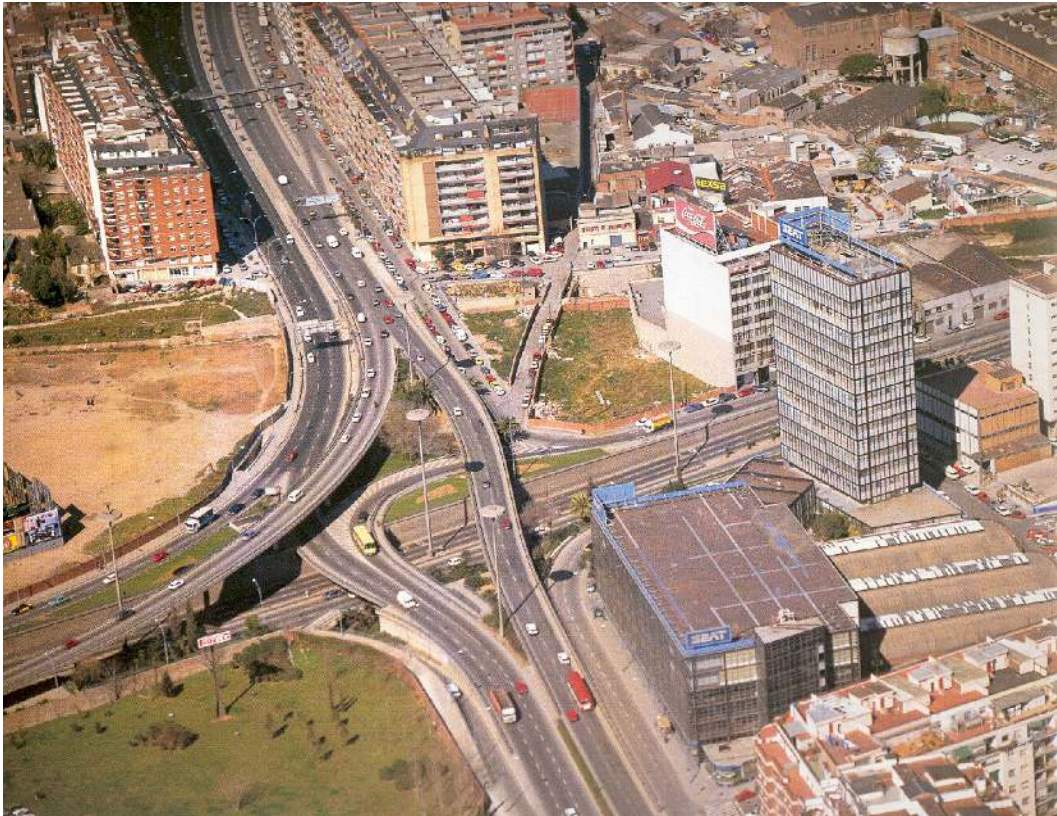
Fig. II / 3.2 / 01: Inicio de la autovía de Castelldefels
