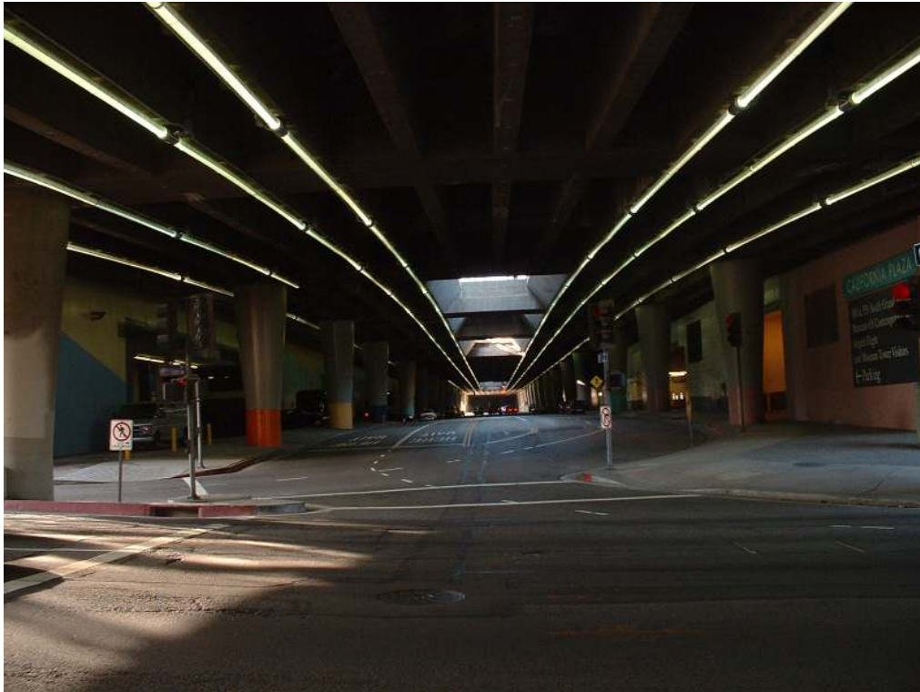
Fig. I / 3.1 / 13: Vial a nivel subterráneo del "Downtown" de Los Angeles
