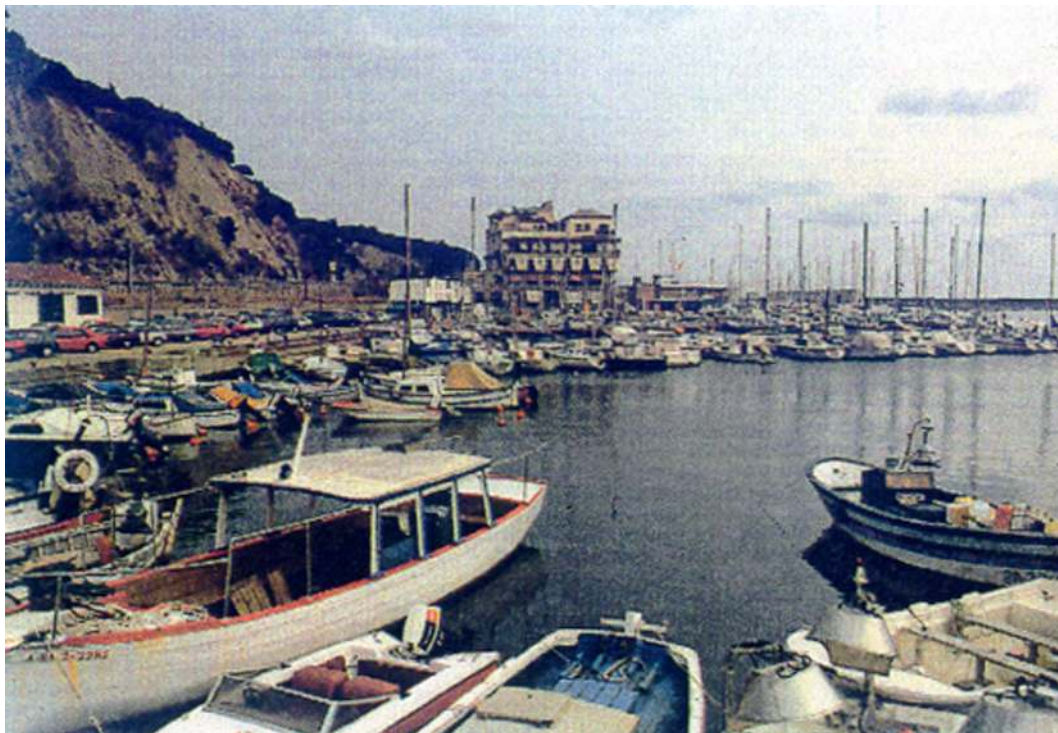
Fig. II / 3.3 / 10: Puerto de Arenys
