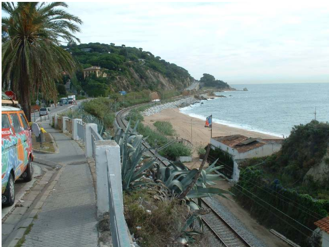
Fig. II / 3.3 / 02: Costa dañada de Sant Pol
