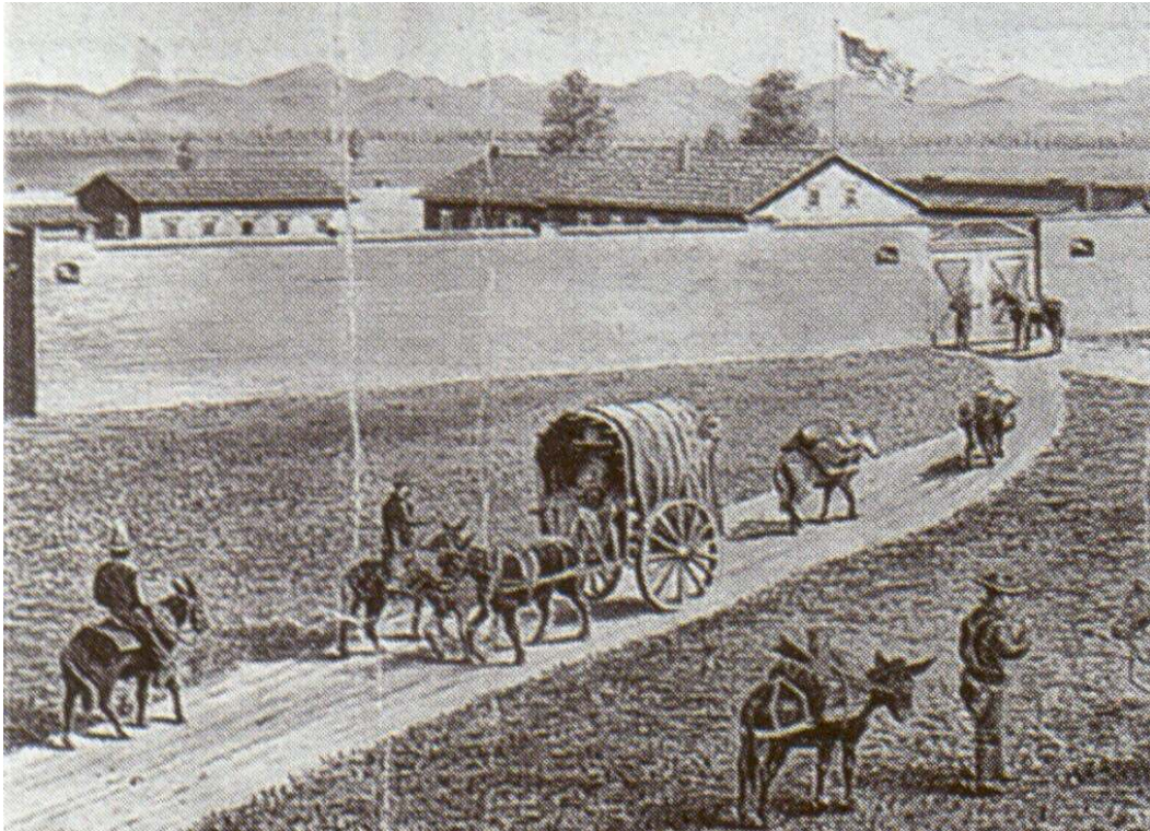
Fig. I / 1.3 / 07: "Fuerter" y "Ranchos".
