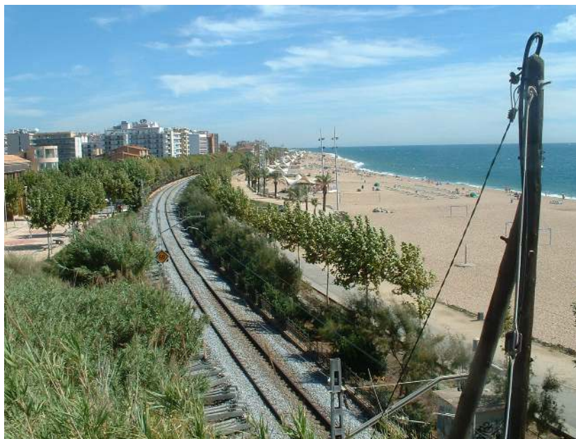
Fig. III / 4.3 / 03: El corte de la vía de Calella
