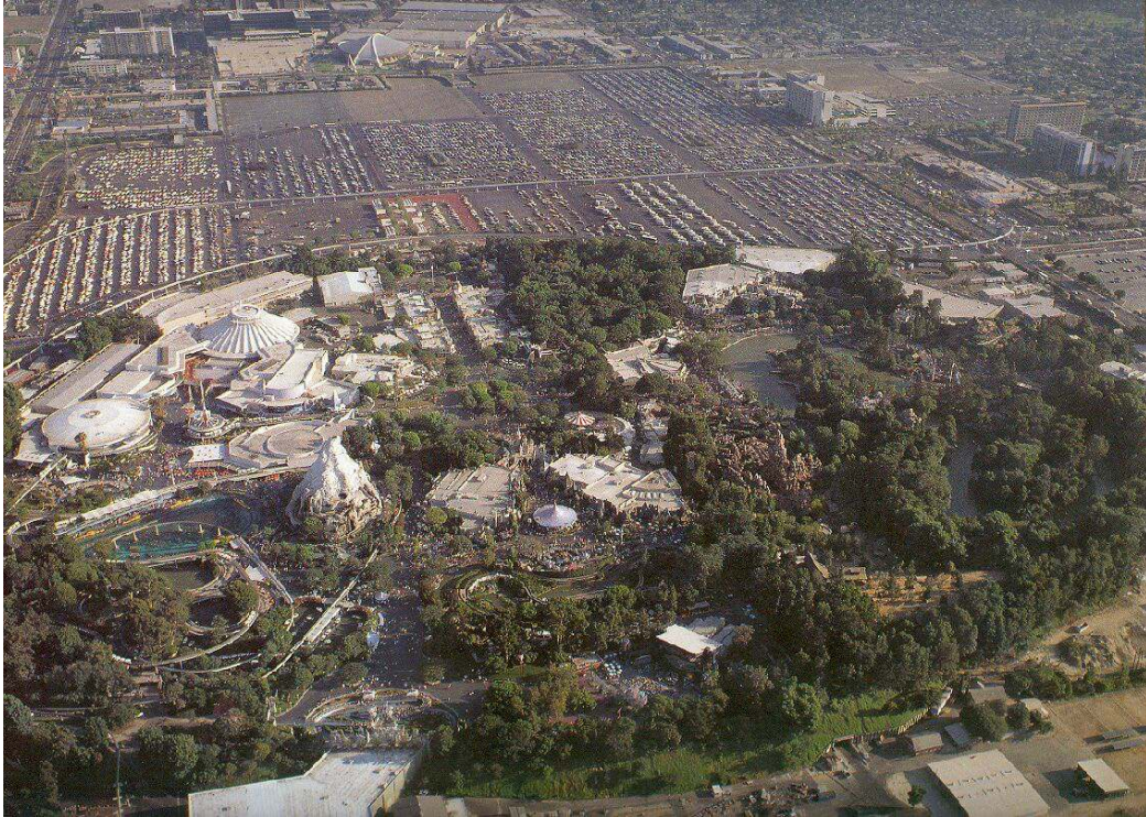
Fig. I / 3.1 / 40: Disneyland antes de su ampliación
