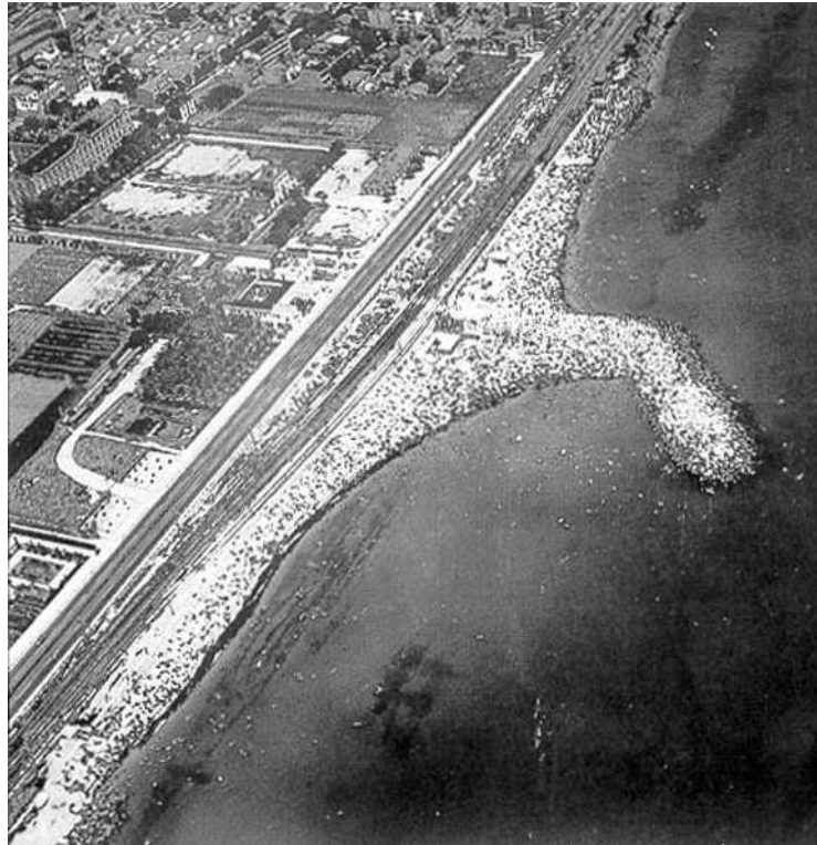
Fig. II / 3.3 / 11: Rompeolas de protección
