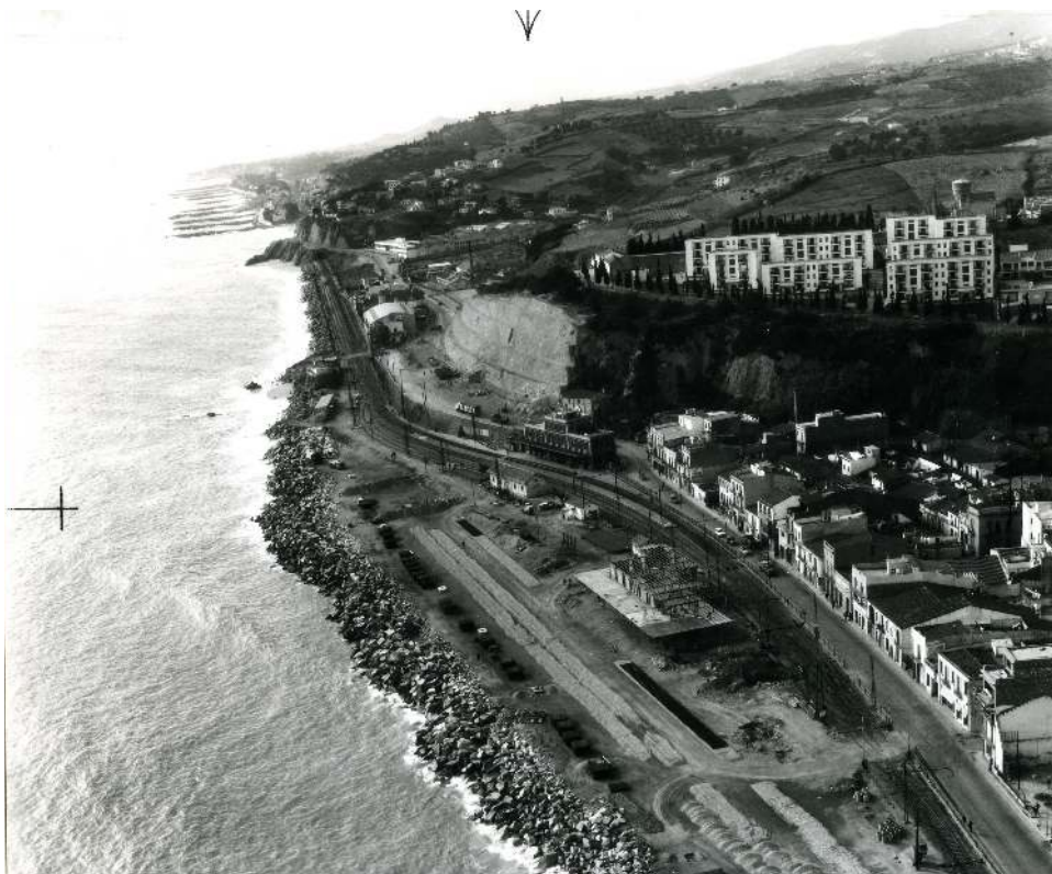
Fig. II / 3.3 / 13: Actuación de infraestructuras de la costa en los años 60 Fig. II / 3.3 / 13: Action of infrastructures of the coast in the years 60
